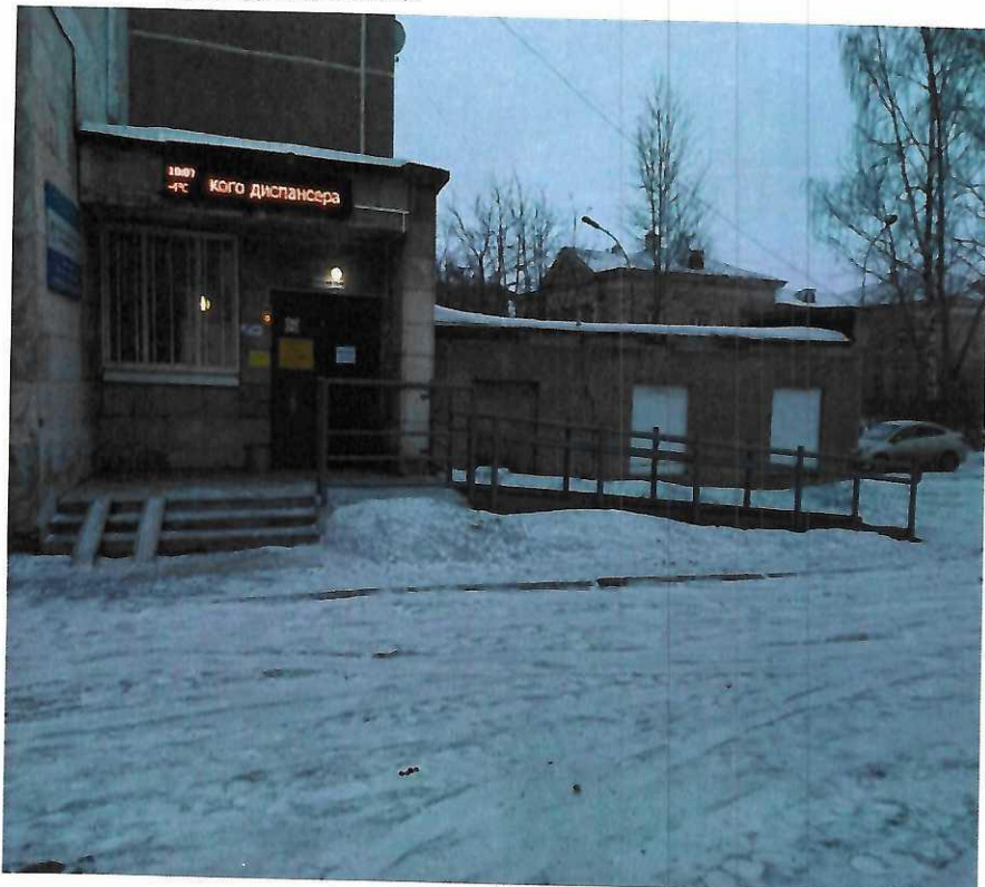
Фото № 5 -Пандус. Наружная лестница.
