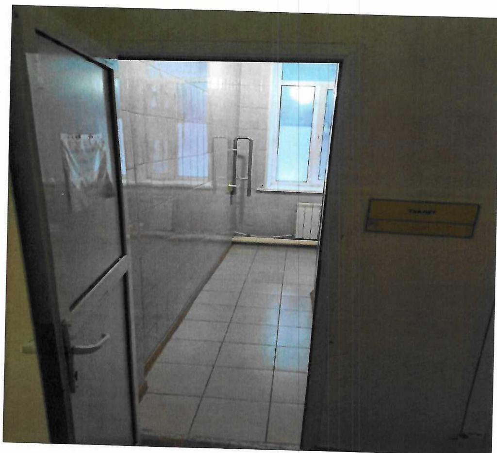
Фото № 15 - Санитарно-гигиенические помещения
