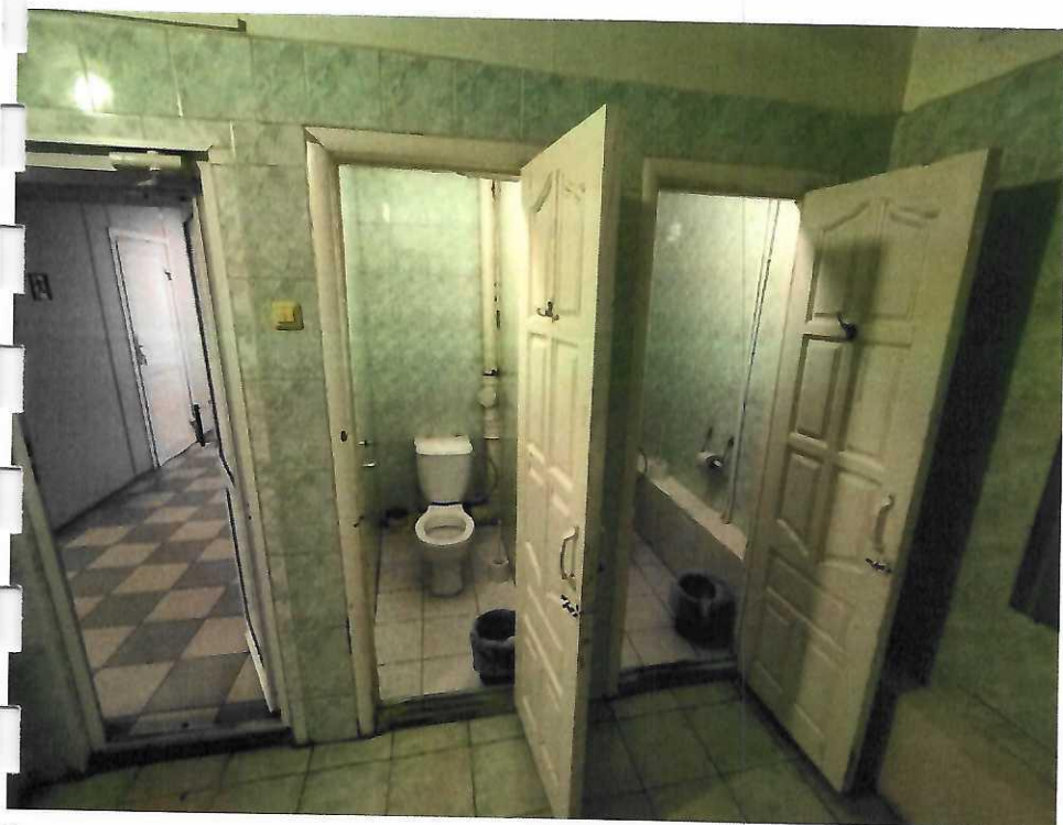
Фото №11 - Санитарно-гигиенические помещения
