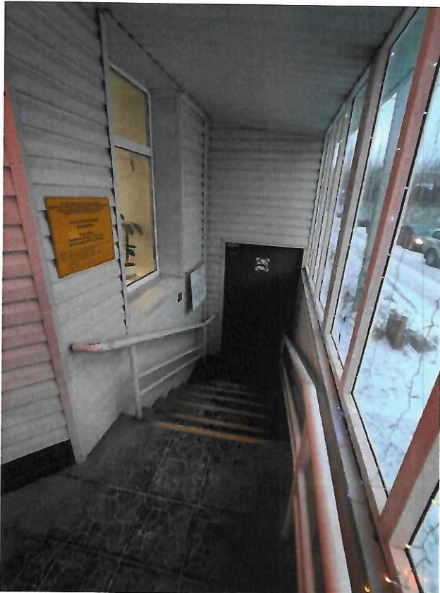
Фото № 6 – Тамбур центрального входа
