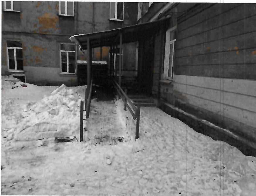
Фото № 4 - Пандус. Наружная лестница.
