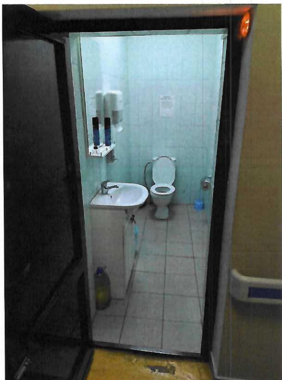
Фото №11 - Санитарно-гигиенические помещения
