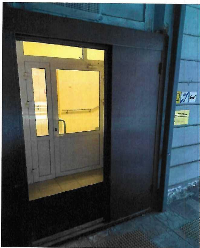
Фото № 5- Наружная входная дверь со стороны хоз. двора (наружный пандус)
